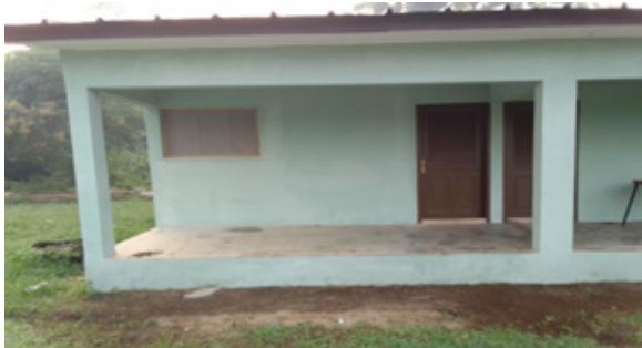
Nouvelle chambre aménagée
